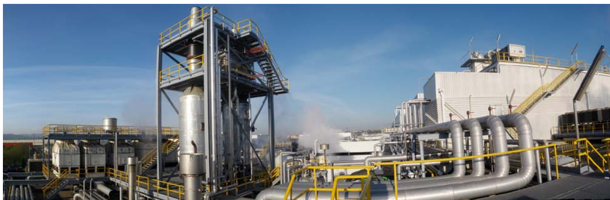
Detalle de la planta de cogeneración de energía de Parets del Vallès, Barcelona.
